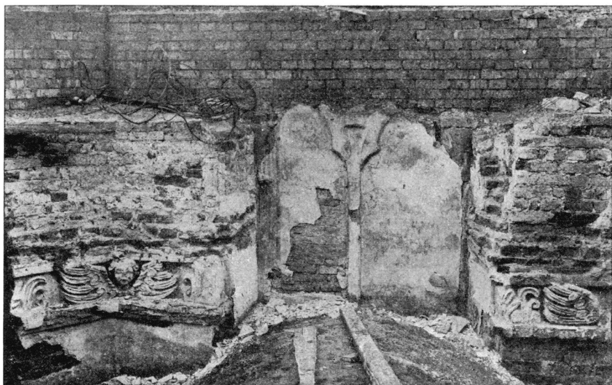
Resztki zdobienia wnętrza prezbiterjum w dawnej farze Witoldowej, pochodzące z czasów przebudowy kościoła za Bony (1551 r.), odkryte na poddaszu kościoła Wniebowzięcia N.M.P. w czasie robót restauracyjnych w lipcu 1922 r. (Fot. autor).
